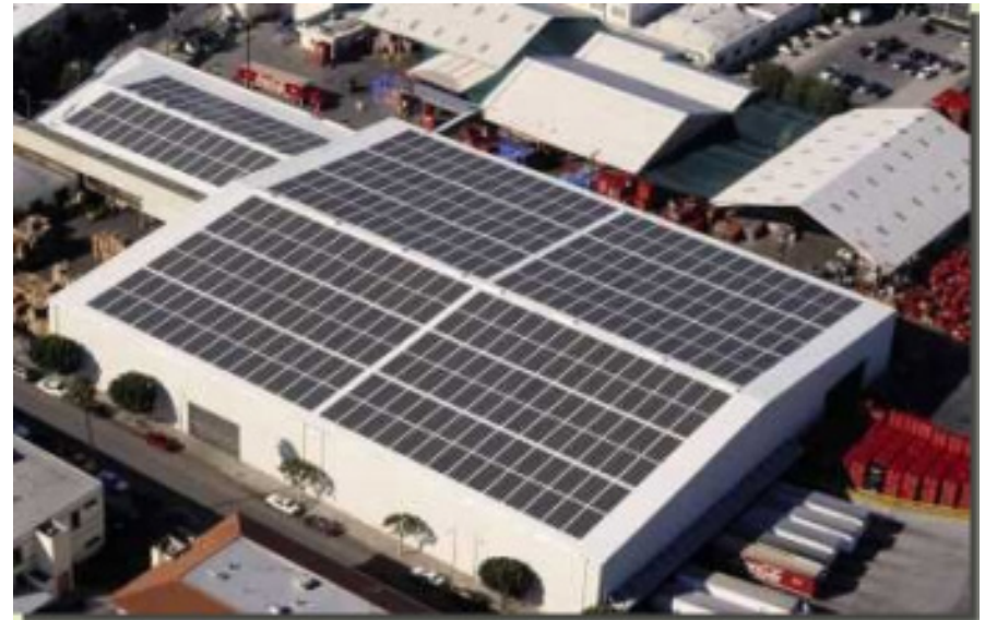
Coca Cola bottling plant, Los Angeles. (379 kW)
